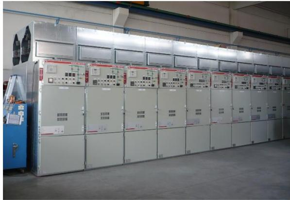
Grado de protección desde IP4X para aplicaciones de interior, hasta IP65 para aplicaciones de exterior.
