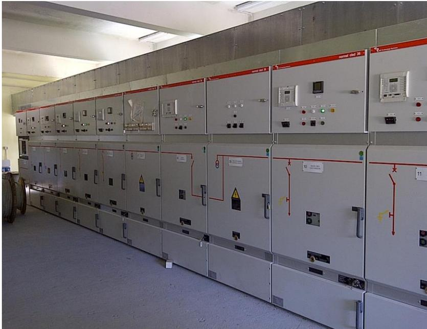
Relé de protección y control, disyuntores aislados en SF6 o al vacío. Personalización de componentes.
